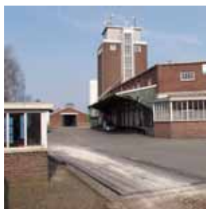
Silo en weegbrug 'Landbouwersbeleg Haaksbergen
