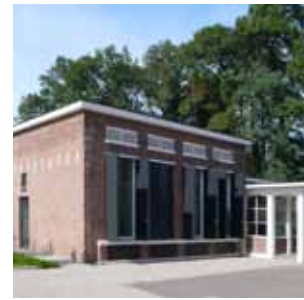
Foodatelier in portiersloge annex trafogebouw
