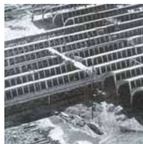
Bijzondere skeletbouw Seahorse-complex in aanbouw
